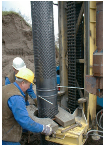
Монтаж стержневого соединения
