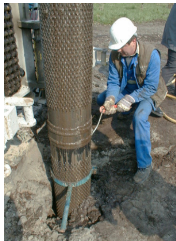
демонтаж поднятого фильтра
